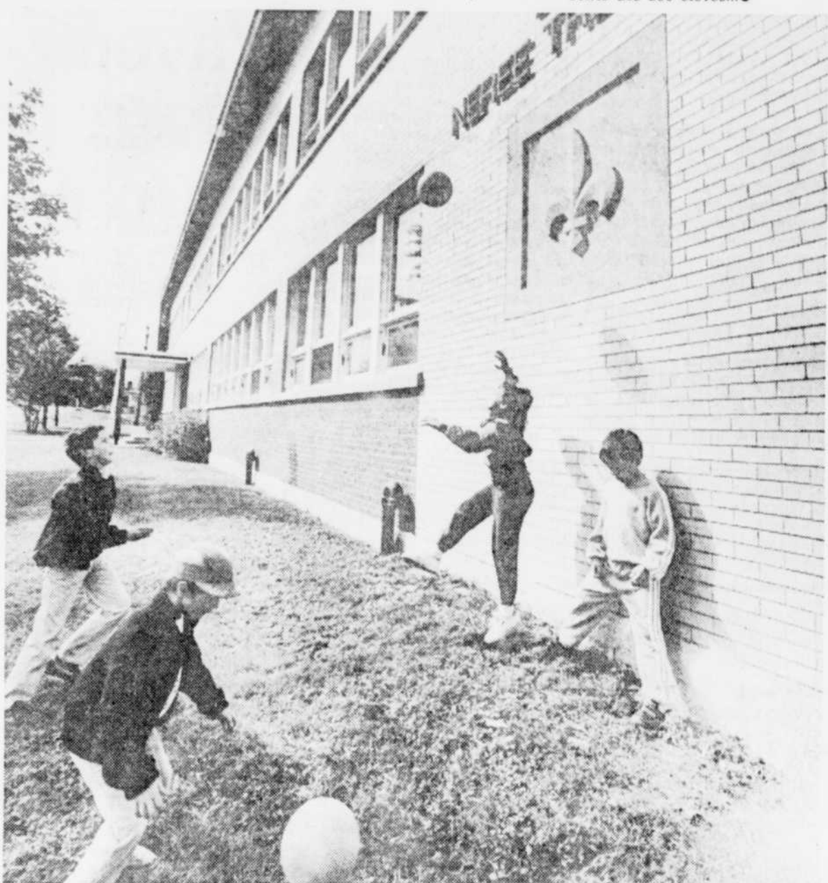
C'est le revêtement d'un plafond de l'école qui serait à l'origine du problème.
