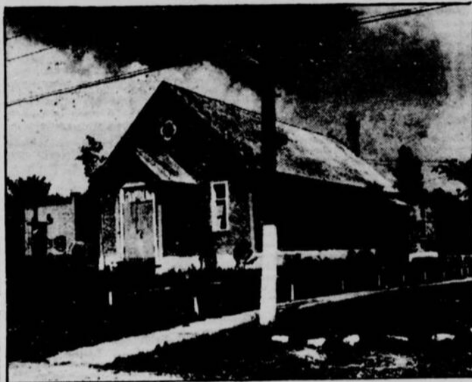
L'église qui sert de résidence à la famille Prévost à Bordeaux. Cet immeuble fut transporté sur rouleaux du bvd Gouin au bvd Persilliers soit quatre coins de rues plus loin.—(Photo la "Patrie")
