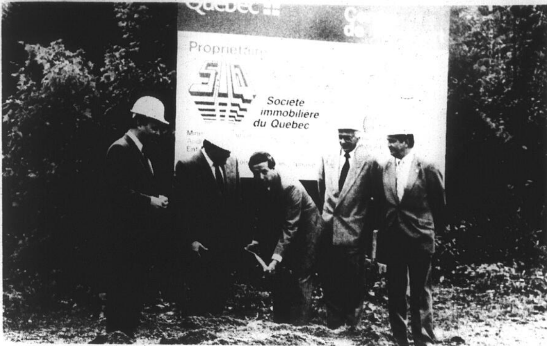
Le ministre André Vallerand a procédé à la levée de la première pelletée de terre du futur Centre de transport de Victoriaville. Il est accompagné ici, de gauche à droite, du maire Denis Saint-Pierre, du député sortant Laurier Gardner, du sous-ministre au Transport Paul Maranda et d'un représentant de la SIQ.
