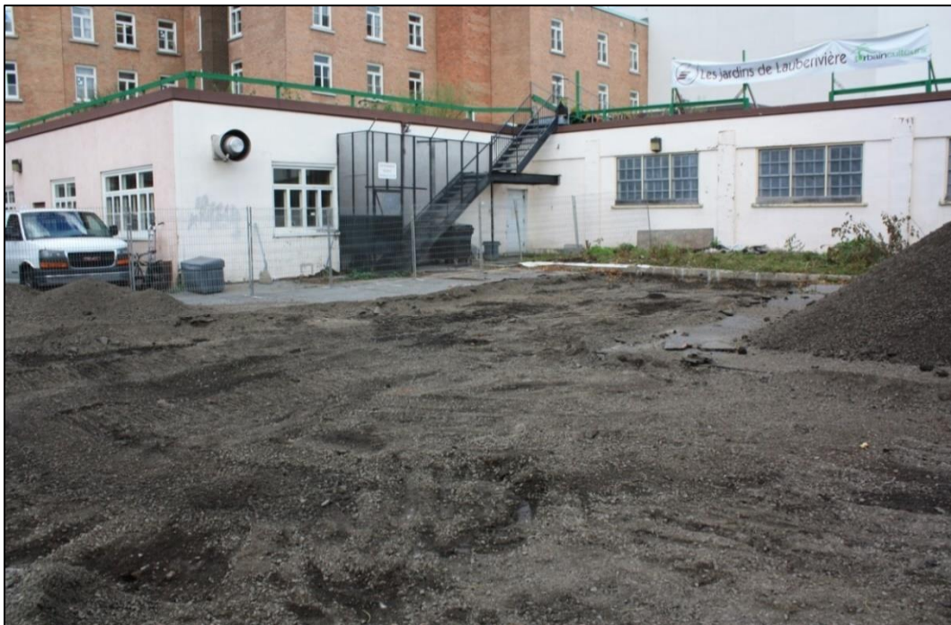
Photo 2. Portion nord-est de la sous-opération 75A après l'enlèvement de l'asphalte, vers le nord-est (CeEt-30-2014-75A-001)
