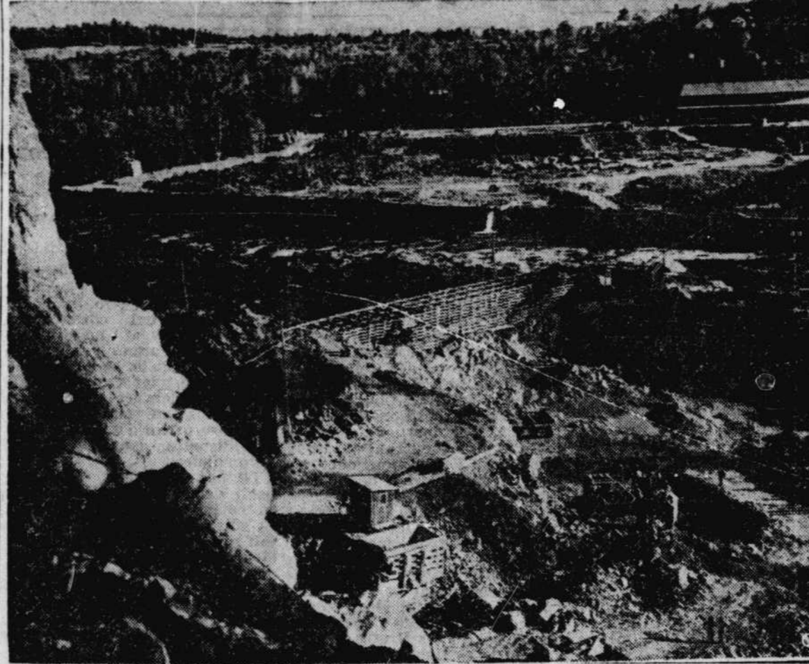
Cette photo du Ministère fédéral des Mines et Ressources naturelles montre les travaux toujours en cours malgré l'hiver pour l'érection d'un barrage et d'une centrale hydro-électrique aux Rapides des Joachims, à 140 milles à l'ouest d'Ottawa, sur le cours supérieur de l'Outaouais. On peut avoir ici quelque idée du travail nécessaire pour détourner provisoirement le cours de la rivière et y ériger l'une des plus importantes centrales du pays. Pour ces travaux, une entente entre le Québec et l'Ontario a été nécessaire. (Photo C.P.)
