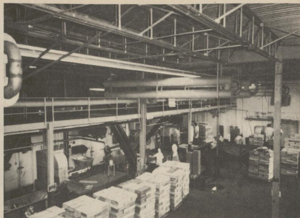
Une vue de l'intérieur de l'usine de congélation de bleuets de St-Bruno.
