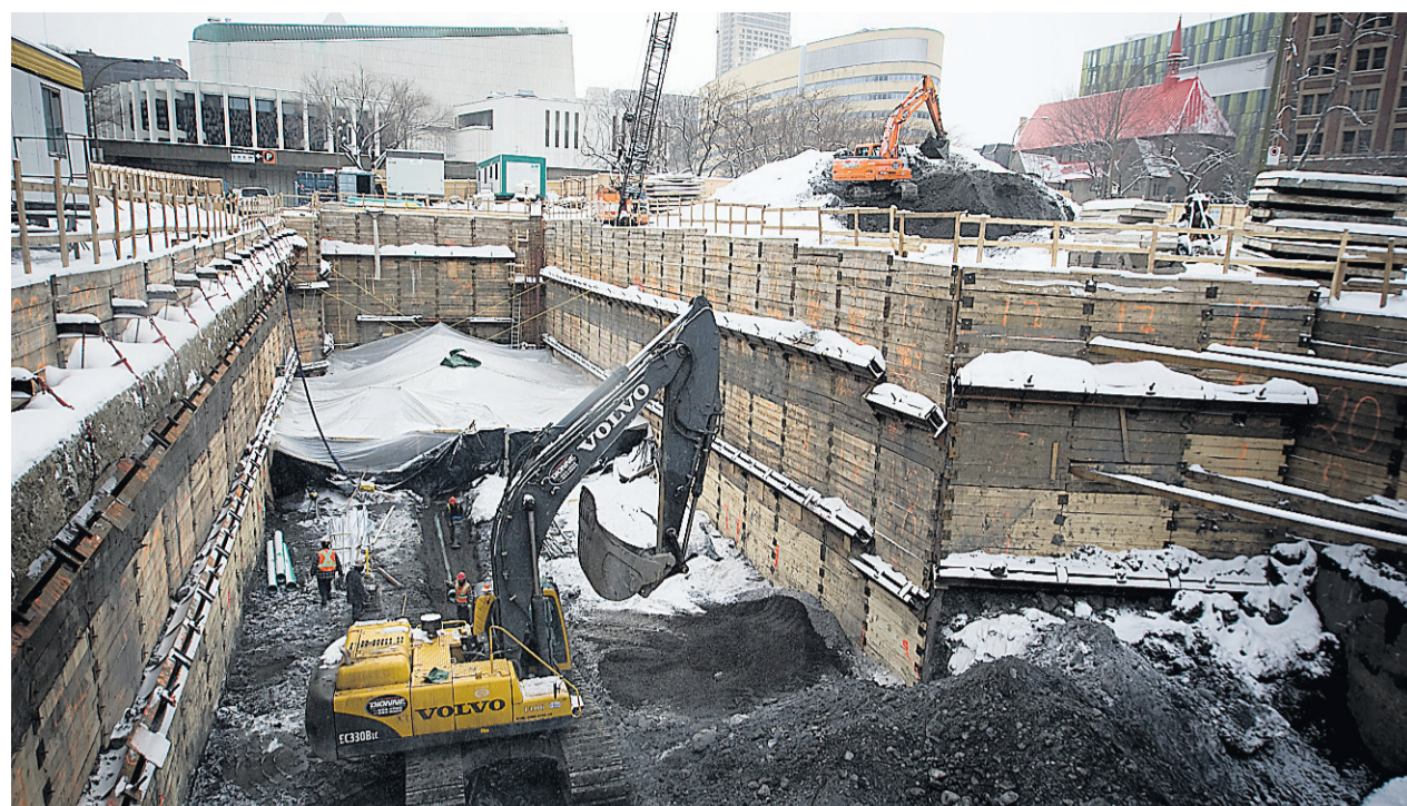
Les travaux du Quartier des spectacles de la Place des Arts, annoncés à 120 millions, frôlent désormais les 150 millions en raison de frais indirects, d'un échancier serré et d'achats de terrain.
