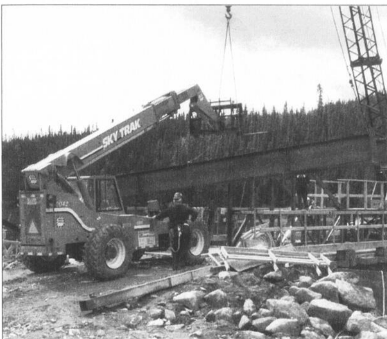
TRAVAUX - Plusieurs entreprises du Saguenay-Lac-Saint-Jean ont profité des retombées du chantier Péribonka IV. Ici, la construction d'un pont.
