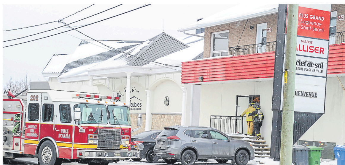
Les dégâts causés par l'eau à la suite d'un début d'incendie provoqué par un feu de friture, au-dessus du commerce almatois Meubles Gilles Émond, s'élèvent à environ 200 000 $ pour l'entreprise. — PHOTO LE QUOTIDIEN, GIMMY DESBIENS
