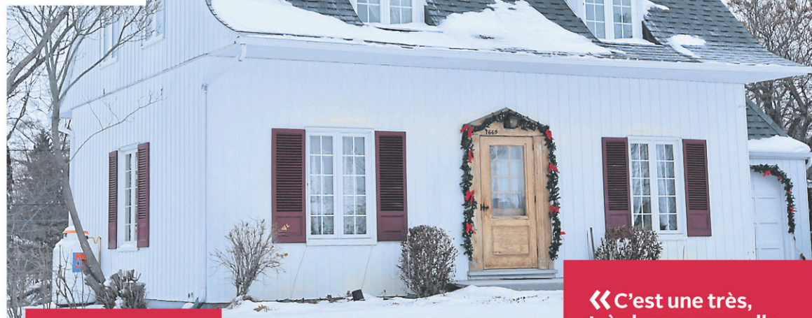
Le patrimoine industriel de l'ancienne ville de compagnie fondée par Alcoa, en 1926, où 270 maisons ont été érigées en 135 jours, fait maintenant partie des sites patrimoniaux reconnus par Québec. — PHOTO LE QUOTIDIEN, MICHEL TREMBLAY
