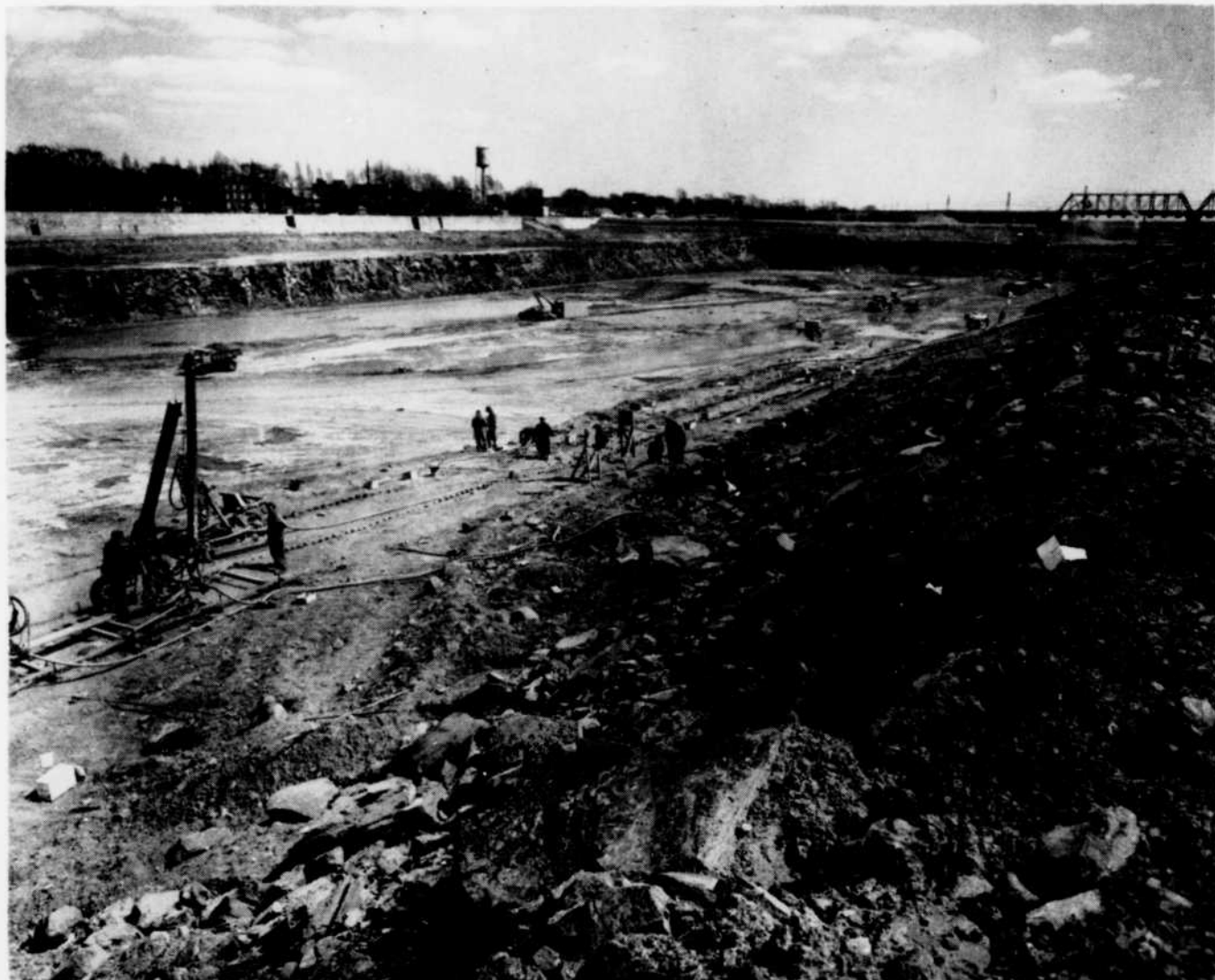
Le canal à St-Lambert (travaux actuels)
