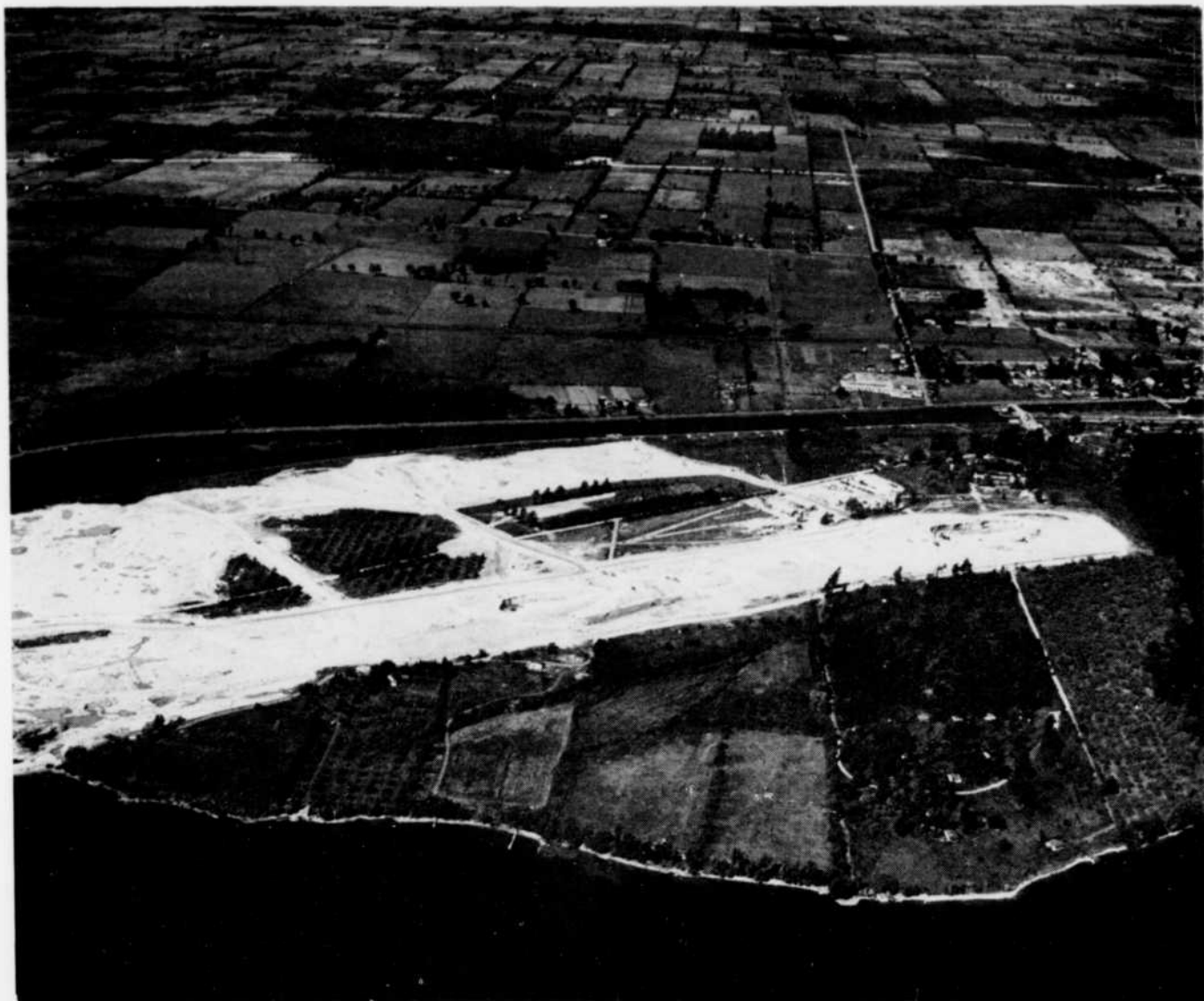
Les travaux à Iroquois, Ontario
