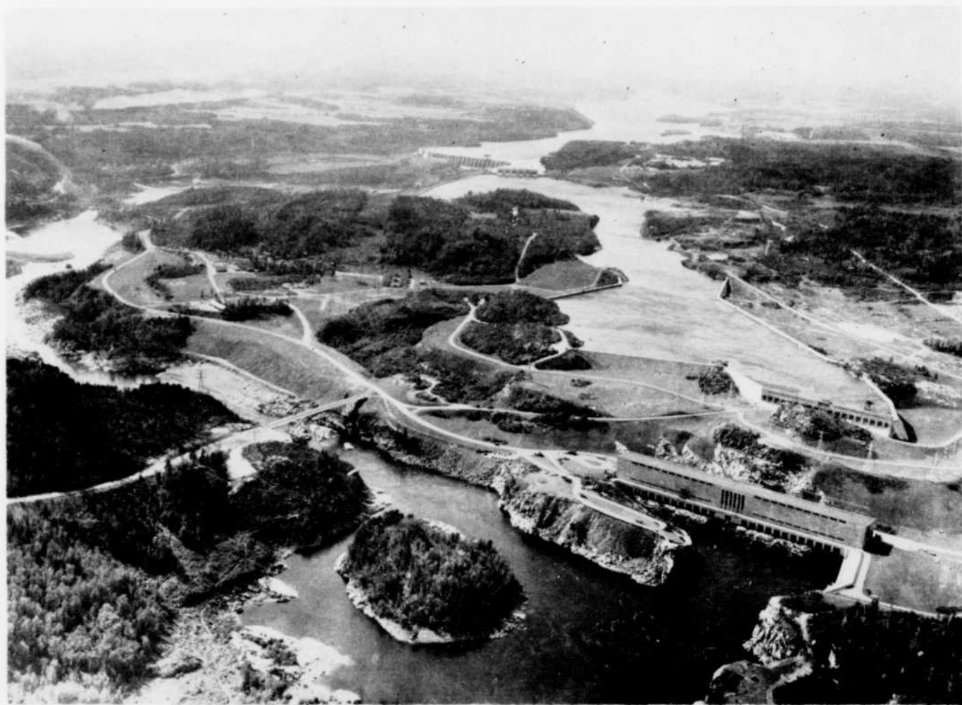
L'aménagement hydroélectrique de Shipshaw situé sur la rivière Saguenay, à proximité d'Arvida, est la plus importante centrale de l'Alcan au Saguenay. A l'avant plan, la centrale numéro II d'une puissance de 1,200,000 h.p. et à l'arrière plan, la centrale de Chute-à-Caron d'une puissance de 300,000 h.p. A gauche, on aperçoit le Pont Arvida, le premier pont routier entièrement en aluminium.
