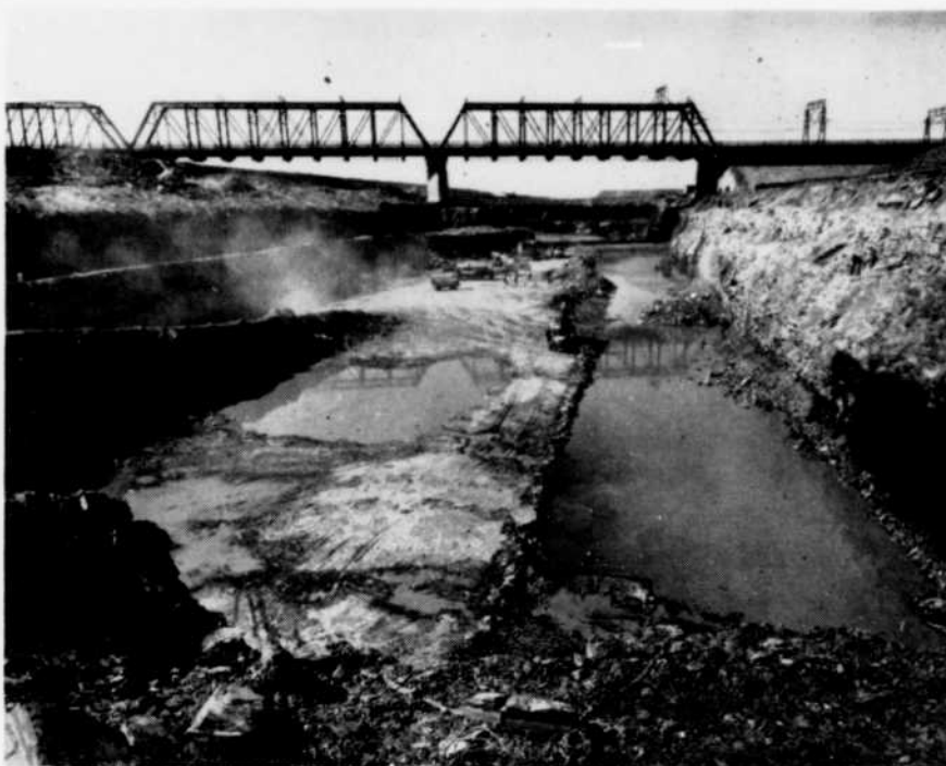
L'écluse de St-Lambert (travaux actuels)
