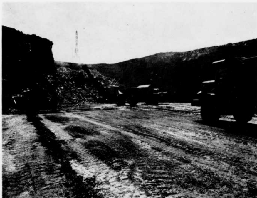
Travaux d'excavation dans la section de Lachine
