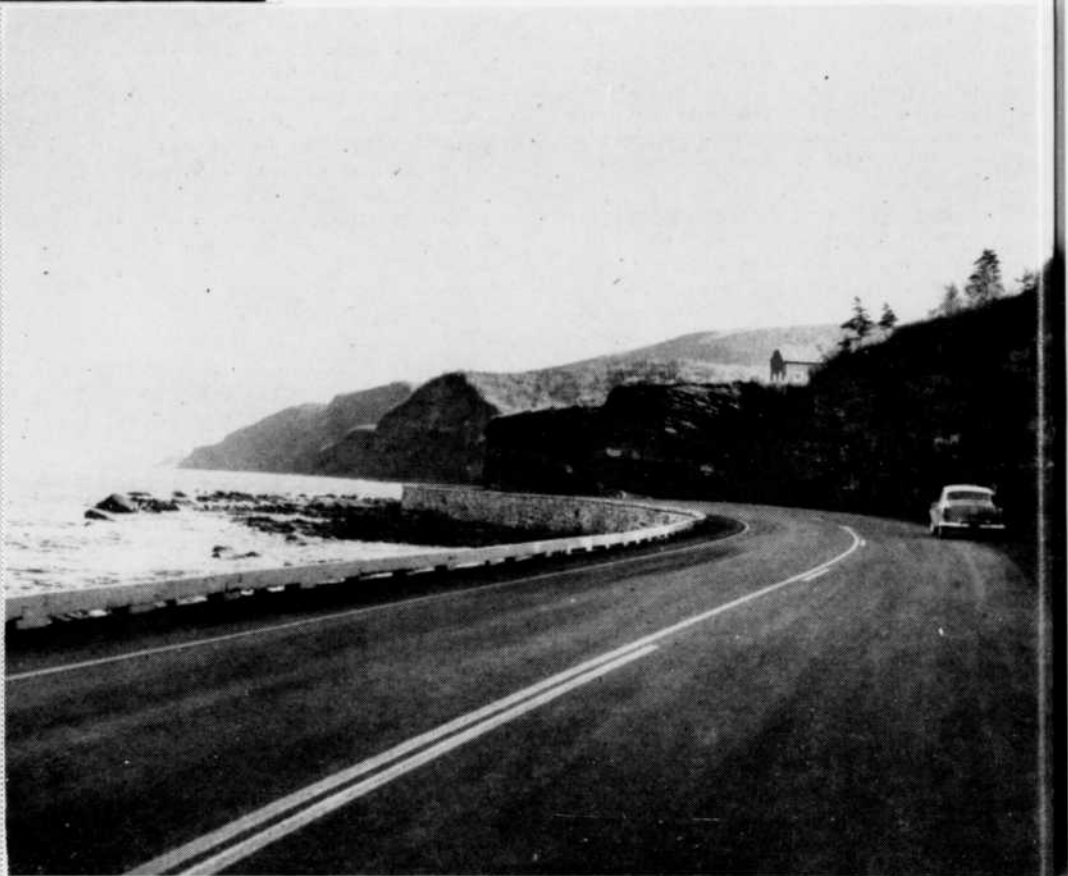
La nouvelle route No 6 à un point situé à l'ouest du village de Gros Morne dans le comté de Gaspé-Nord.
