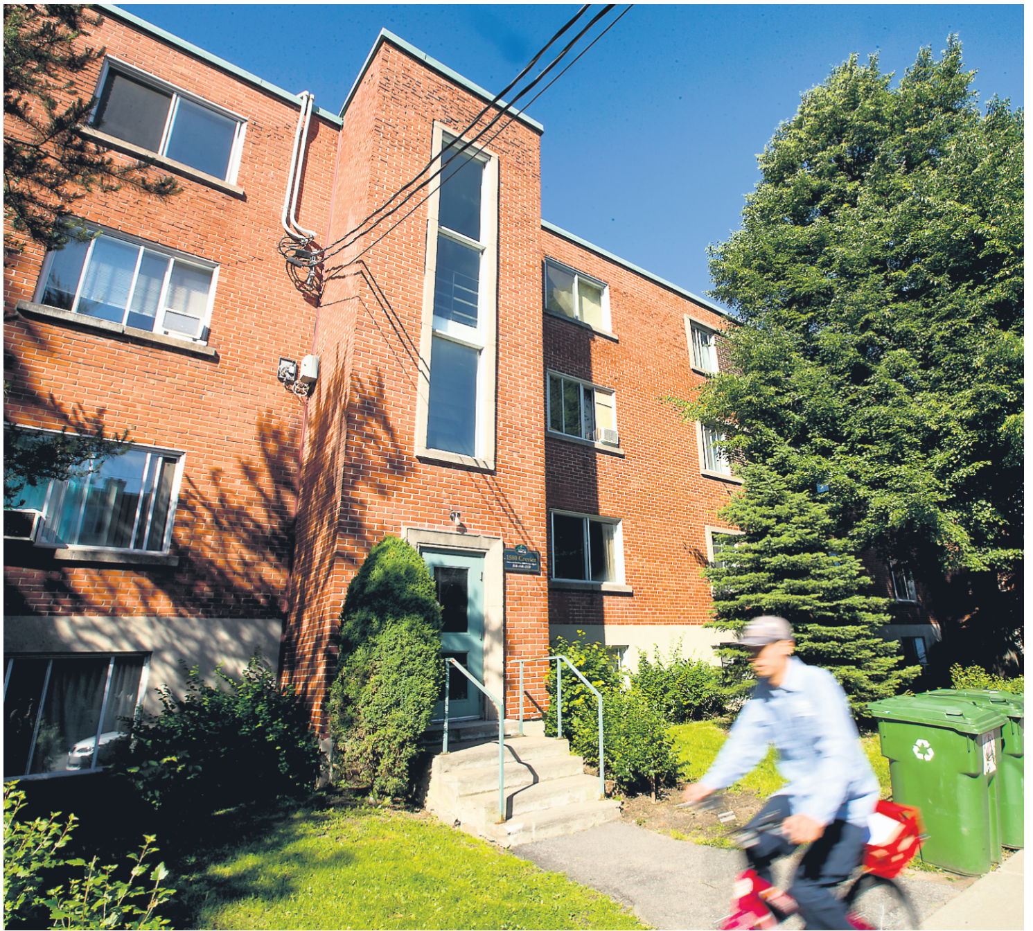
Les autorités de l'arrondissement de Saint-Laurent ont à l'œil les immeubles gérés par MetCap. Depuis 2013, il y a eu 664 logements inspectés, 38 avis d'infraction envoyés, 11 logements placardés et 16 logements évacués pour cause d'insalubrité.
