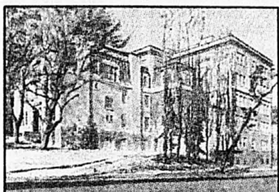
La «nouvelle» Maison Redford. À gauche, le pavillon «original» et à droite la nouvelle maison de cinq étages.
