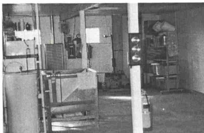
VUE DE L'AIRE D'UTILITÉ
