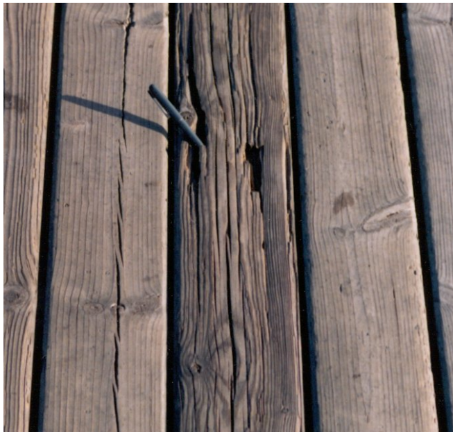
Photo 2.4-2 – Pourriture moyenne d'une pièce de plancher
