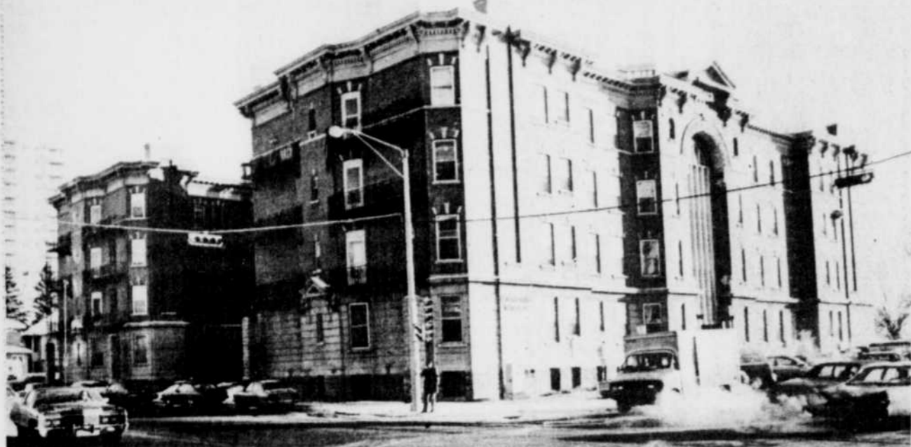
La maison Le Marchand, un immeuble à quatre étages, en forme de H, a été achevée en 1912 au coût d'environ $200,000. Elle comportait un ascenseur, un portier et des foyers naturels dans chaque appartement. L'immeuble de briques rouges, à Edmonton, a été l'objet de controverses
