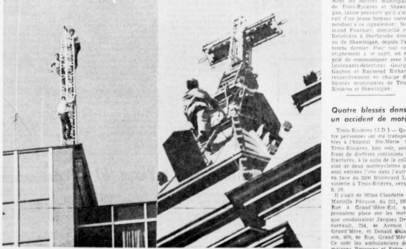
NOTRE EPOQUE se prête bien à l'exploration des airs. Trois-Rivières n'échappe pas à cette règle, comme en font foi les deux photos ci-haut. A gauche, une équipe d'employés érige une tour sur le toit de l'édifice Royal tandis qu'à droite un employé de la firme Bourassa Inc, M. Jocelyn Bourassa procède à la réfection d'une partie du système électrique d'une des croix du clocher de l'église St-Philippe. (Photo Roland Lemire)
