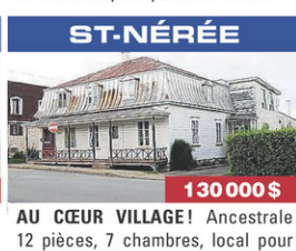
ST-NÉRÉE 130 000$ AU CŒUR VILLAGE! Ancestrale 12 pièces, 7 chambres, local pour travailleur autonome, garage, hangar.
