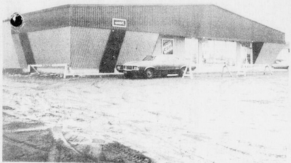
Le marché d'alimentation MCP Inc. est situé sur le boulevard Vachon à Ste-Marie.
