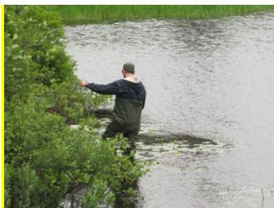
Figure 3 : Installation d'une bourolle dans le ruisseau Moreau.
