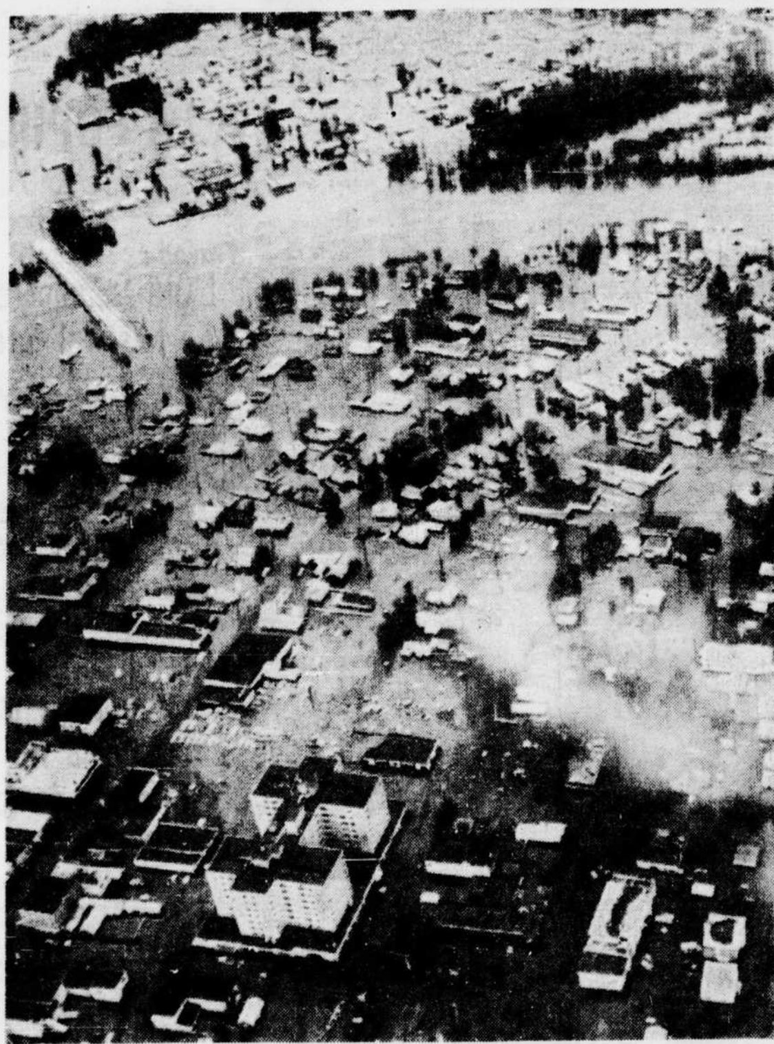
● FAIRBANKS INONDEE — Cette vue aérienne de la basse-ville de Fairbanks, en Alaska, donne une idée de l'étendue de l'inondation qui a fait cette semaine plus de $200 millions de dégâts et forcé quelque 14,000 personnes à quitter leurs logis ravagés par les eaux de la rivière Chena. (Téléphoto UPI)
