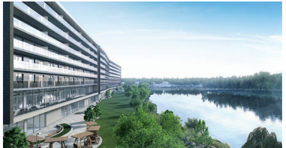
Le Sélection Deux-Montagnes, tel qu'il se présentera une fois la construction terminée.
