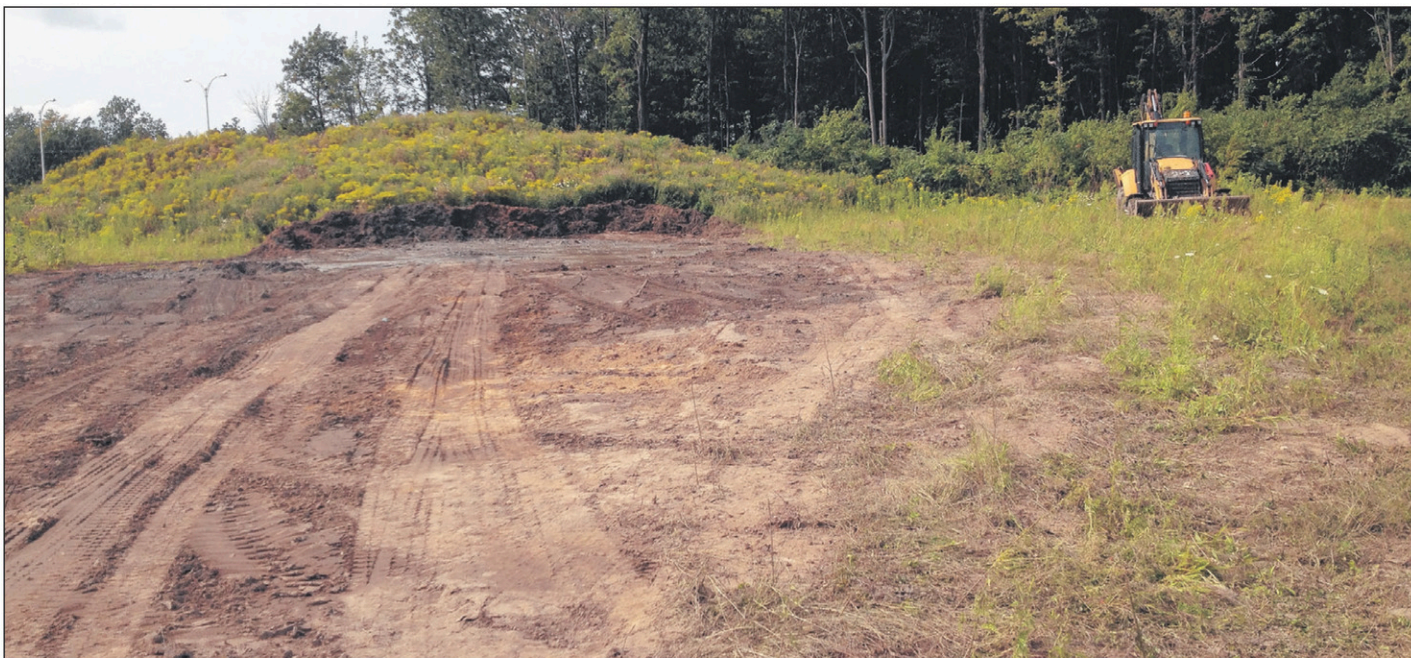
Les déblais d'excavation ont été déposés sur un terrain appartenant à la compagnie Sicam.
