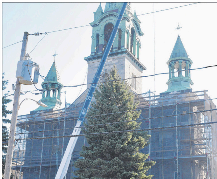
Les échafaudages seront visibles jusqu'à la fin de septembre.
