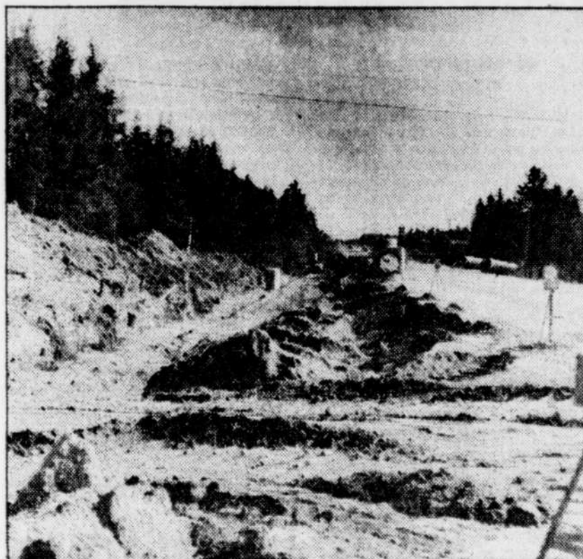
Deuxième phase des travaux d'élargissement à quatre voies de la route 112 dans les limites de Black Lake.
