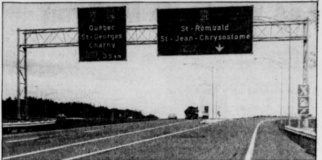
La sortie 318 donne accès à Saint-Jean-Chrysostome et à Saint-Romuald, mais par le biais d'une intersection dangereuse.
