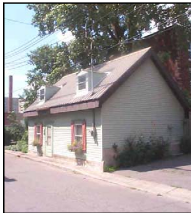
À gauche, maisons sans marge de recul de la rue Saint-Dominique. À droite, petite maison de faubourg de la rue Lagarde. PMR562 et PMR775.
