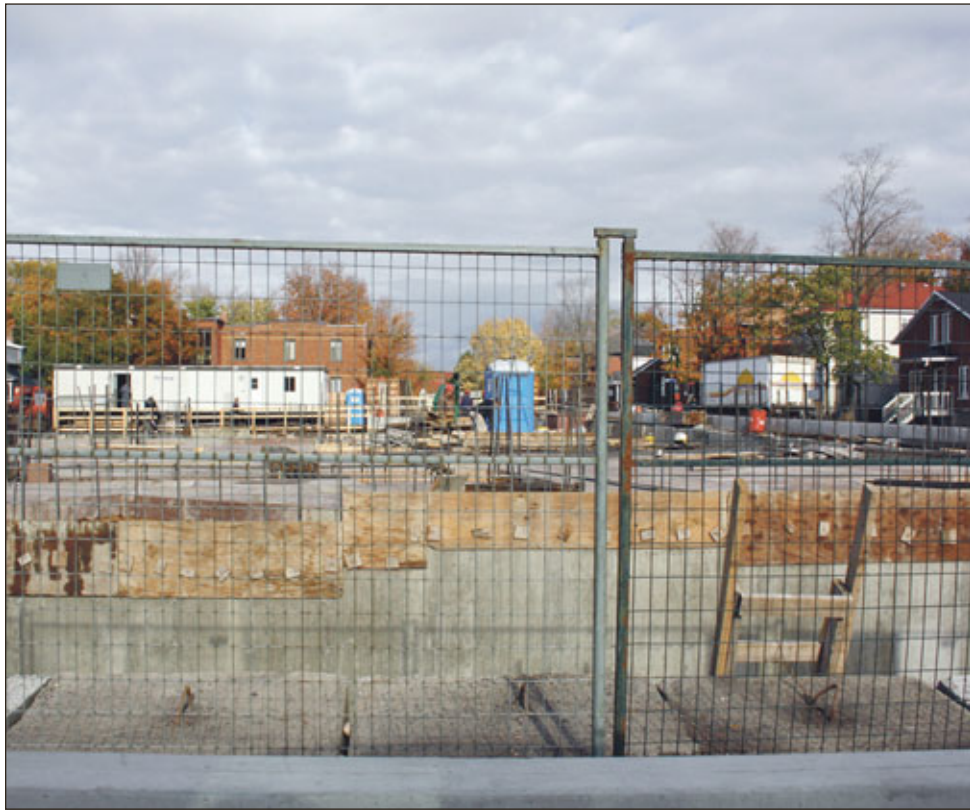
Les travaux se poursuivent comme l'échéancier prévu au nouvel immeuble de la Place d'affaires Maguire.
