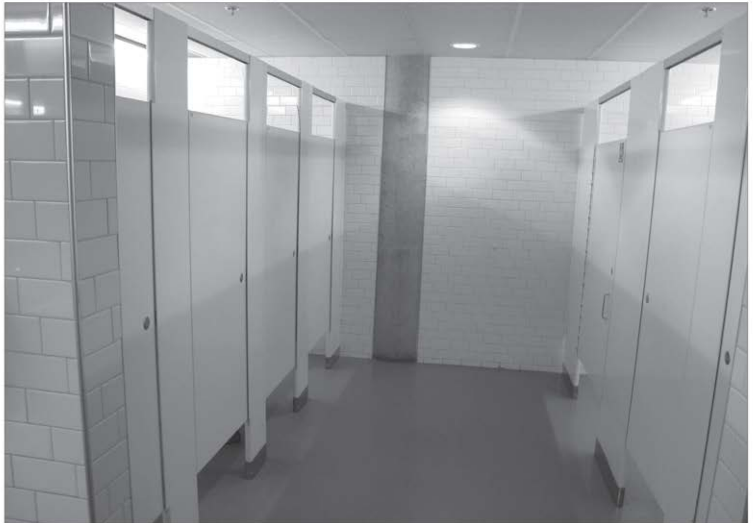
Les portes qui ne se ferment pas elle-même contribuent à amplifier le problème
