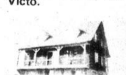
12e rang, Saint Louis-de-Blandford. Construction récente. SIM.
