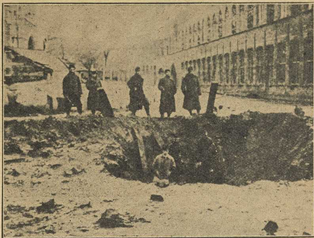
Le trou produit par la chute d'un gros obus allemand; dans l'excavation creusée plusieurs hommes peuvent se tenir à l'aise, il ne faut donc pas s'étonner des ravages que ces obus produisent sur les bâtiments. Il ne faut pas oublier cependant que les Alliés ont à leur service une artillerie supérieure à celle des allemands et que lors de l'invasion en Prusse, il y aura de la casse...
