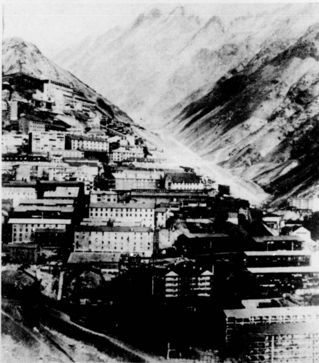
La plus grande mine de cuivre souterraine au monde, celle de El Teniente, à 50 milles de la capitale. Elle emploie 7.000 ouvriers.
