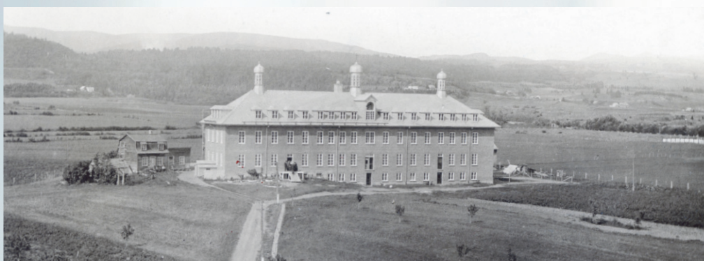
5 1918, Nouveau pavillon « La maison Saint-Joseph », sur le site de l'actuel hôpital.
