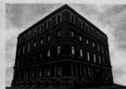
Installation de Pipon Agora de la danse Photo_Pipon
