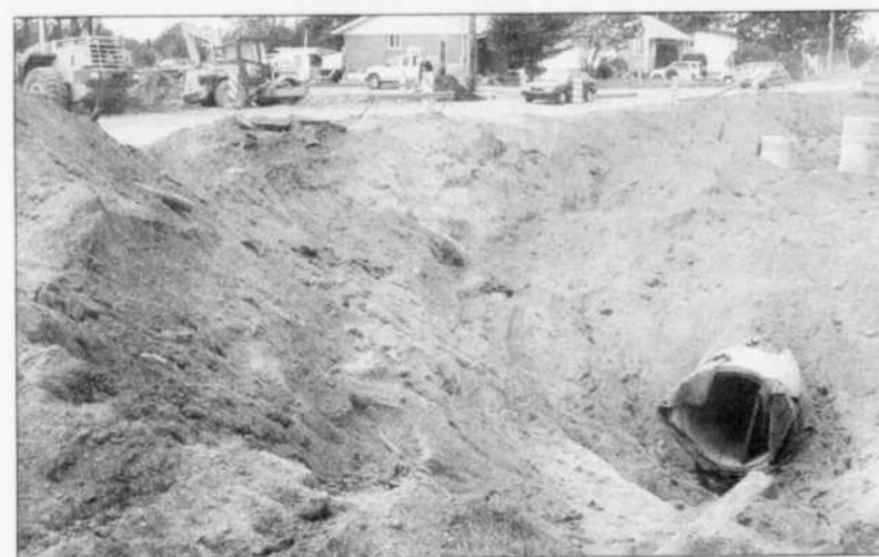
INSTALLATION— Travaux d'installation de tuyaux, sur le boulevard St-Jude, à Alma.
