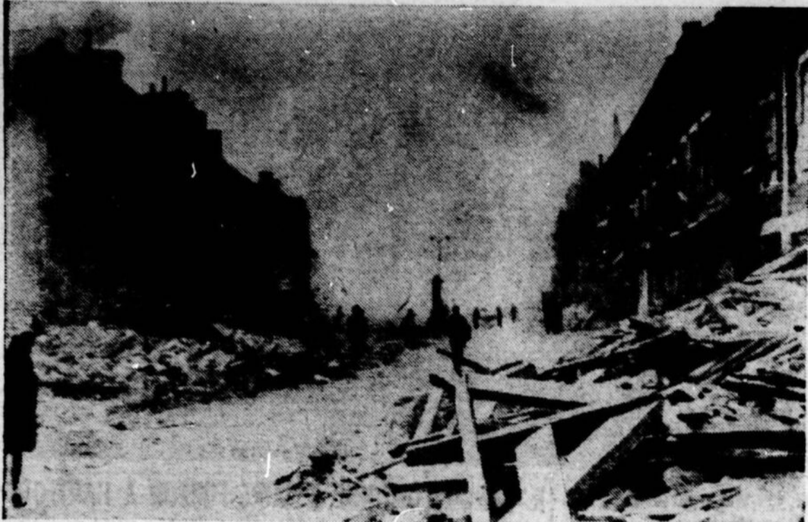
De la fumée et des amas de débris remplissent la rue principale de la ville, d'Issigny, en France, à la suite d'un violent bombardement allié qui en a chassé tous les francs-tireurs nazis. Des soldats alliés font l'inspection des immeubles ravagés ou intacts, afin d'y découvrir tout Allemand qui s'y cacherait.
