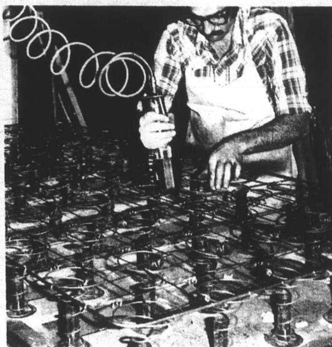
Les ressorts sont ici installés à l'intérieur du cadre d'un sommier.
