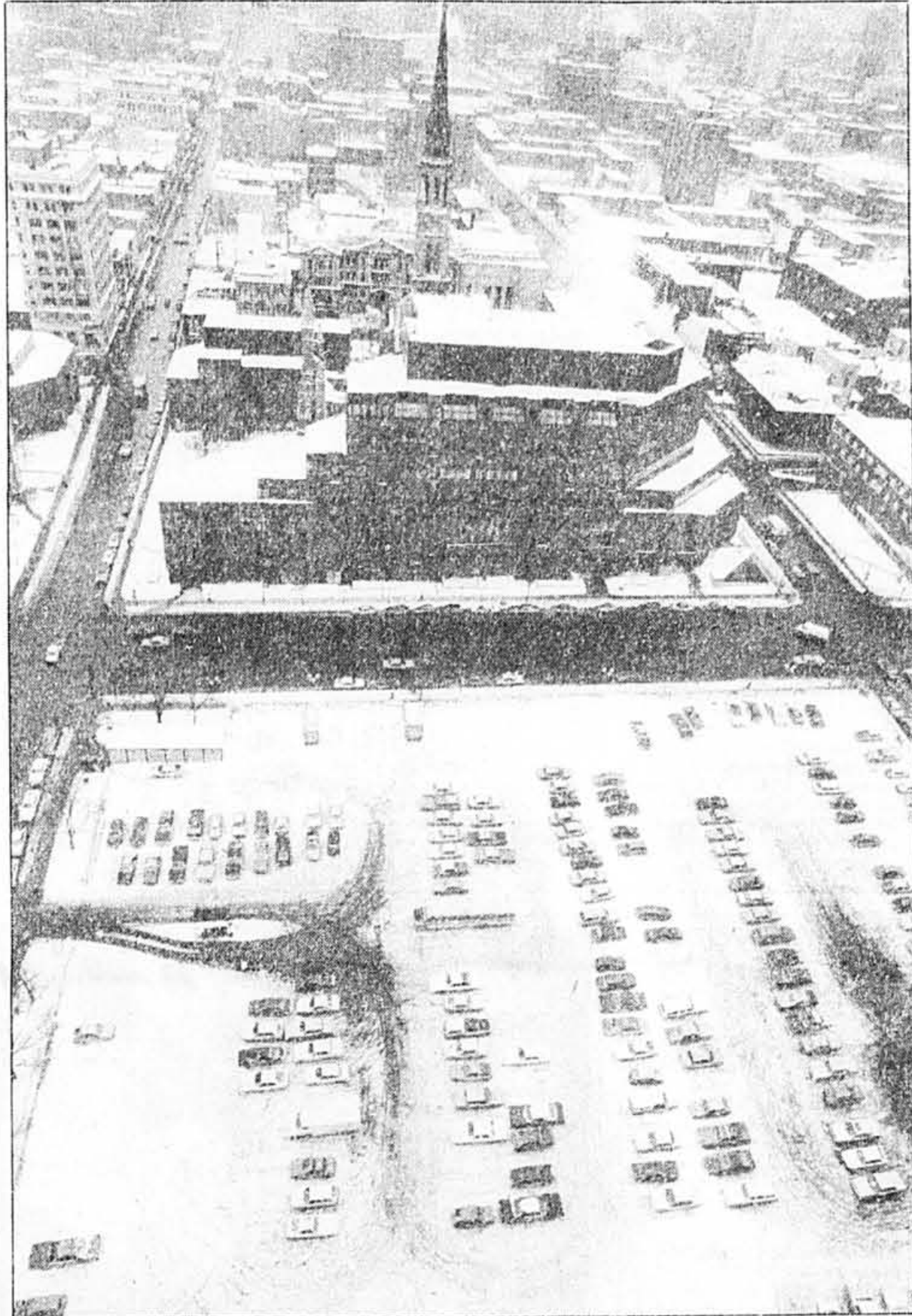
Vue aérienne du terrain de stationnement, angle Sainte-Catherine et Berri, où Sofati entend construire la salle de concert. Immédiatement à l'ouest, l'UQAM, qui intègre les restes de l'église Saint-Jacques. Au nord, le Terminus Voyageur qui pourra amener aux concerts des milliers de visiteurs, selon le maire. En sous-sol, la plus importante station de métro, Berri-De Montigny.
