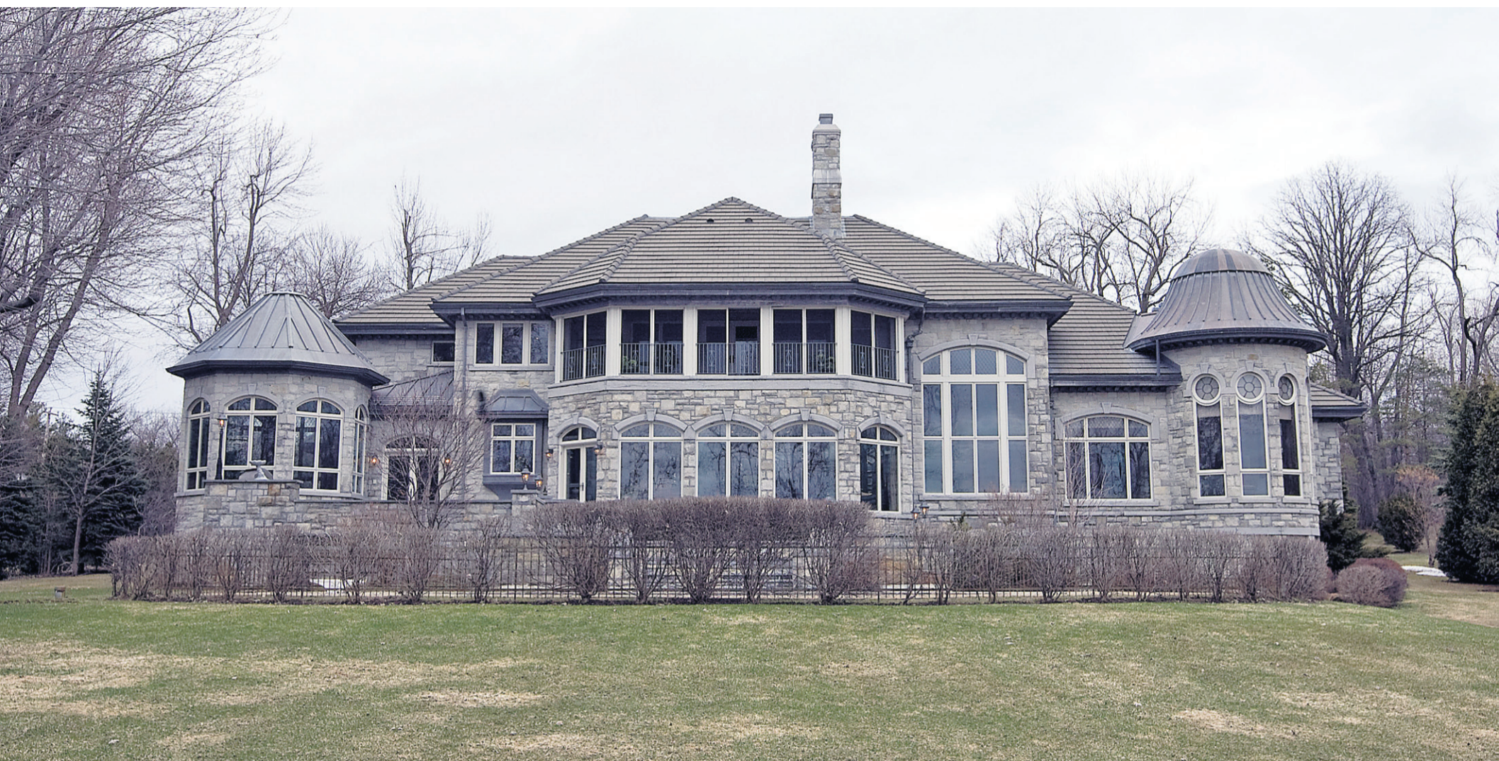
Une digue a été construite pour protéger l'aménagement paysager d'éventuelles inondations. Une telle construction serait interdite aujourd'hui.
