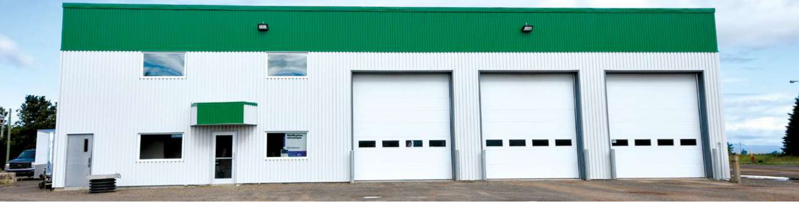
■ Siège social de Transpro BSL et atelier mécanique pour le Centre de service Saint-Philippe
