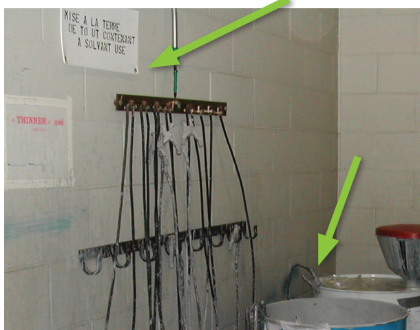
Consigne « Mise à la terre de tous les contenants de solvant usés ».
