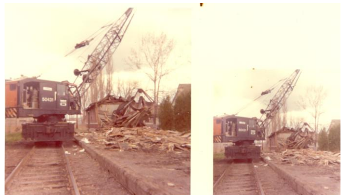
Démolition en novembre 1978!
