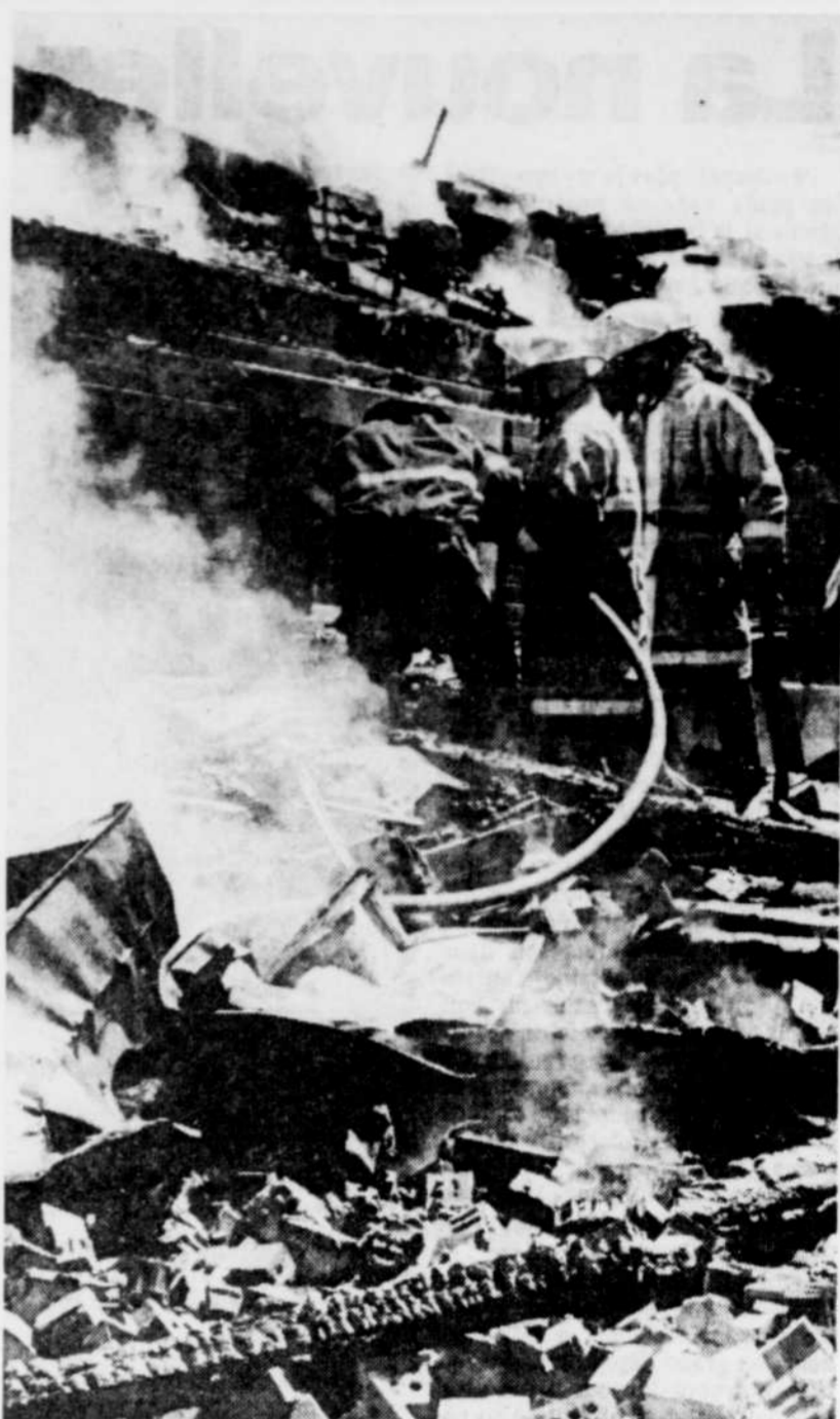
Une trentaine de pompiers, dont ceux de la ville de Rimouski, ont combattu l'élément destructeur durant six heures. Le feu a complètement anéanti les trois étages du bâtiment de briques, conçu pour accueillir 200 élèves du deuxième cycle du primaire.
