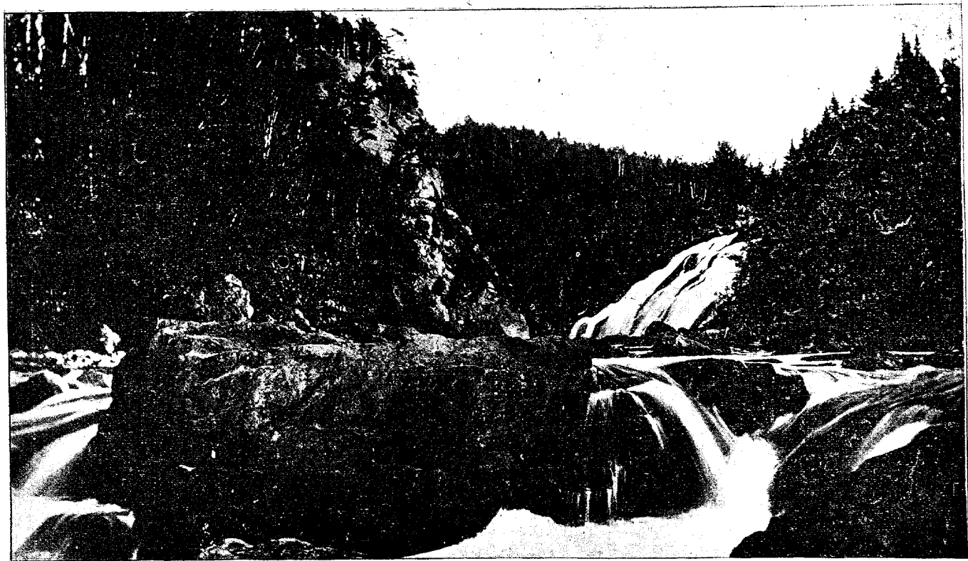
CHUTES DE LA RIVIÈRE DU LOUP.
