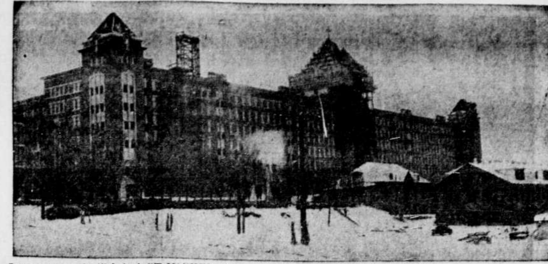
Les travaux de l'hôpital ST-MICHEL-ARCHANGE progressent rapidement. La pose de la couverture est terminée et celle de la briques est sur le point de l'être. La photographie ci-dessus nous donne une idée exacte de l'aspect que présentera la façade de cet édifice de sept étages et de plus de six cents pieds de longueur. Au corps principal de la bâtisse s'ajoutent à l'arrière trois autres ailes ayant à peu près les mêmes dimensions. Dès le mois de mars prochain, croit-on, on pourra commencer à loger des malades dans une des ailes de l'hôpital. L'hospitalisation sera faite à mesure que les travaux intérieurs seront terminés dans chacune des parties de cet édifice. (Photo du "Soleil").
