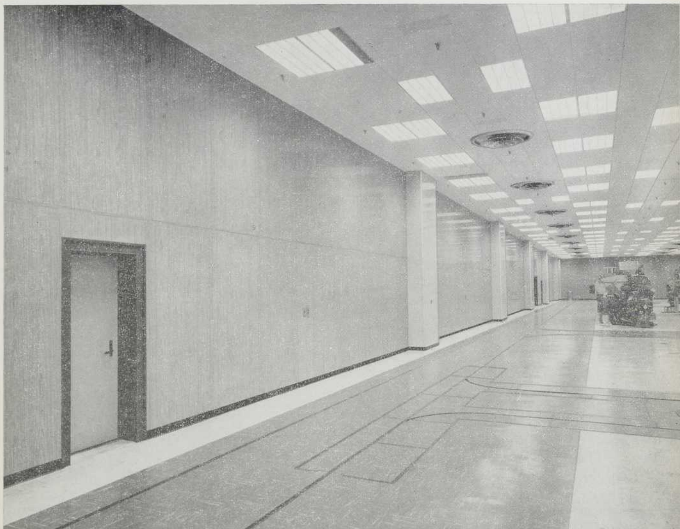
Revêtement mural en Arborite dans la salle de fabrication des cigarettes de la nouvelle usine d'Imperial Tobacco Co. of Canada Ltd., à Guelph.
