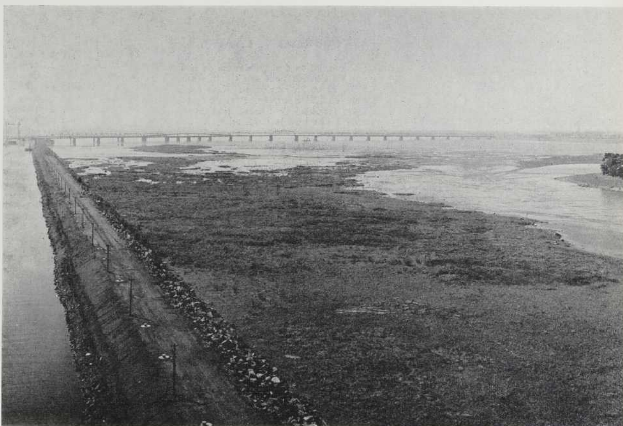
Aspect de terrains de remplissage, en bordure de la voie maritime.
