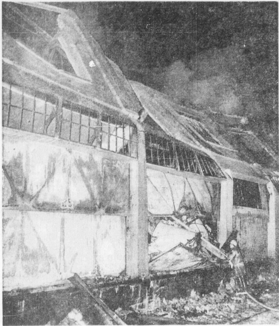
TOUT N'EST QUE RUINES là où était située l'ancienne gare maritime du Foulon à la suite d'un incendie qui fait rage encore aujourd'hui. Les flammes ont causé pour plus de $2,000,000 de dommages. On estime que plusieurs pompiers devront demeurer sur les lieux pendant quelques jours afin de finir d'éteindre
