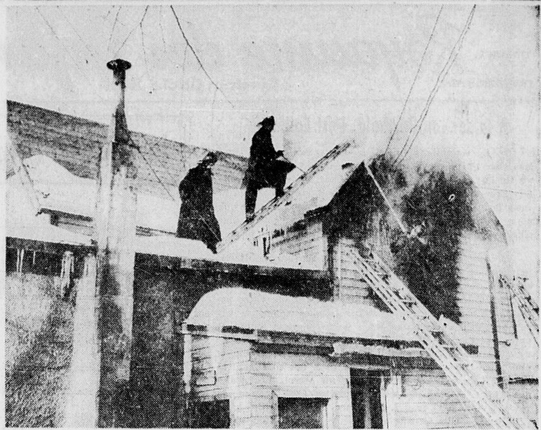
Un incendie a jeté quatre personnes sur le pavé hier après-midi, et a fortement endommagé un restaurant et un logement privé, à 131, rue Main, angle Springhurst. Les flammes se sont déclarées à 2 h. 55 et les pompiers ont dû les combattre par un froid glacial de 15 degrés sous zéro. On voit ci-dessus la maison incendiée. (Photo "Le Droit"—par Champlain Marcell)
