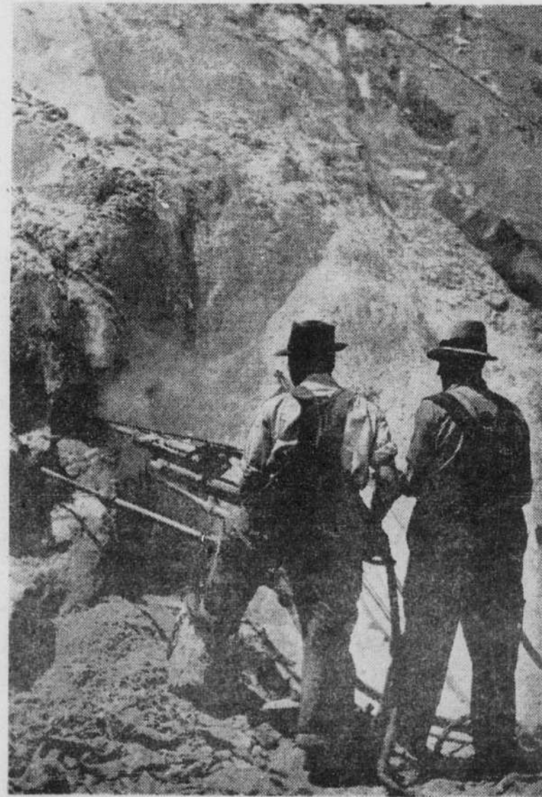
Ouvriers préparant à la foreuse mécanique le dynamitage du minerai d'amiante à la mine de la Compagnie Bell à Thetford Mines; cette mine a 250 pieds de profondeur.
