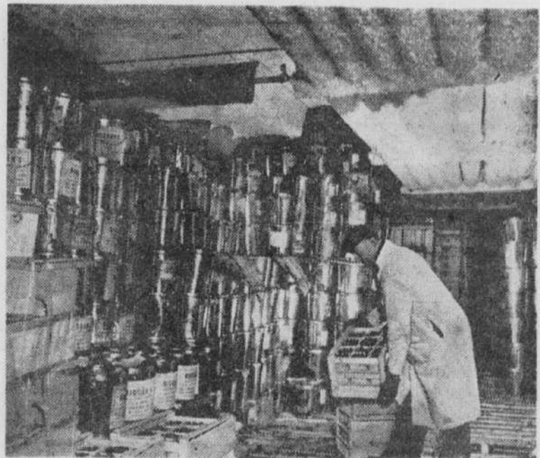
Une salle d'entrepôt. A noter au plafond les tuyaux enveloppés de frimas. Dans cette section, on prévient avec soin tout indice de détérioration.
