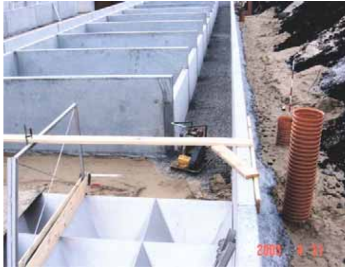
Figure 17. Biofiltre à la construction
