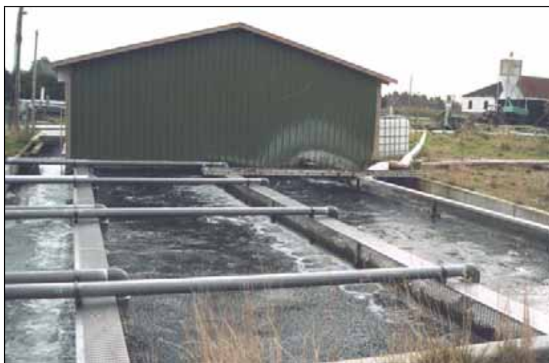
Figure 13. Biofiltre de type submergé à lit mobile
