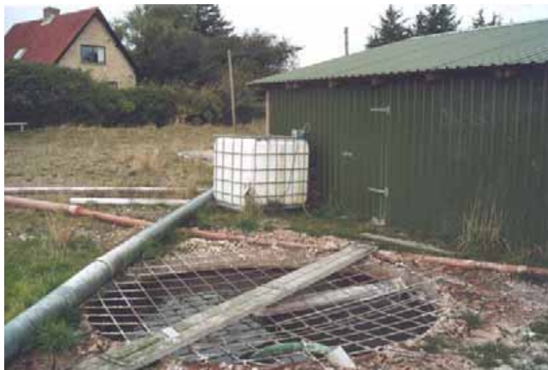
Figure 12. Bâtiment des filtres rotatifs et bassin d'accumulation des boues de lavage avec injection d'alun
