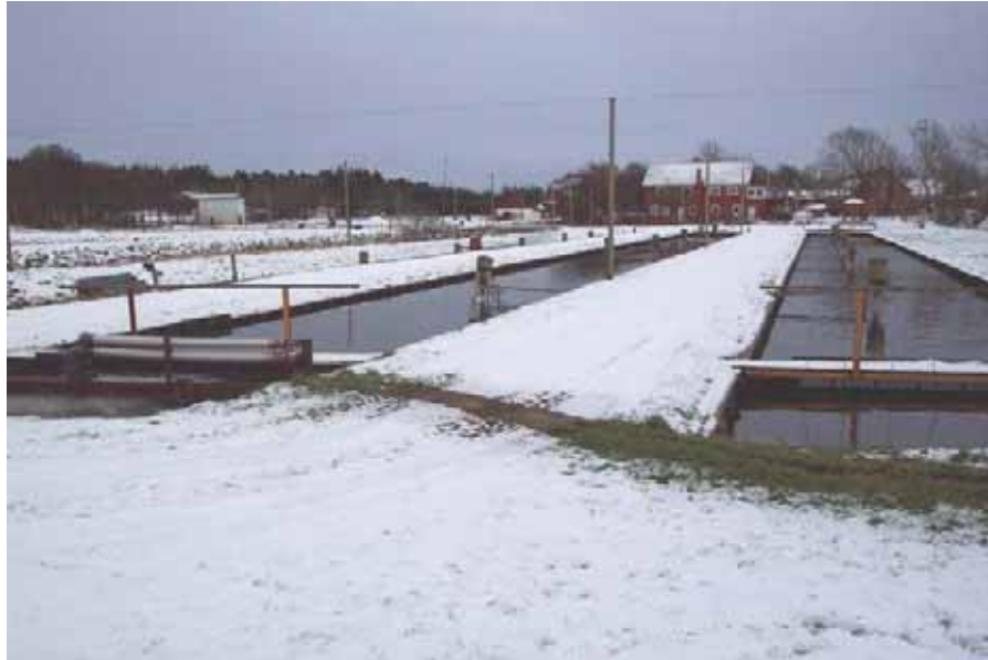
Figure 25. Ferme GL. Råsted Dambrug. Les raceways en terre ont des côtés en bois et un système de recirculation partielle pour économiser l'eau
