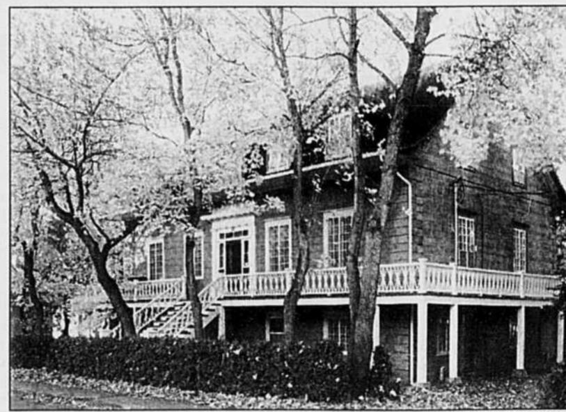
La maison seigneuriale de 1844 a été conservée dans un état exceptionnel.
