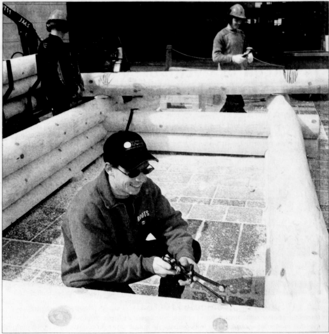
Le compas est l'outil « étalon » d'une construction en bois rond. C'est par lui que les billes se superposent et s'accordent parfaitement.
