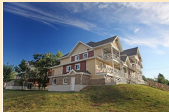
Les logements de HOM sur la rue Broad.
